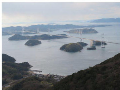
大島・亀老山展望台より 来島大橋
